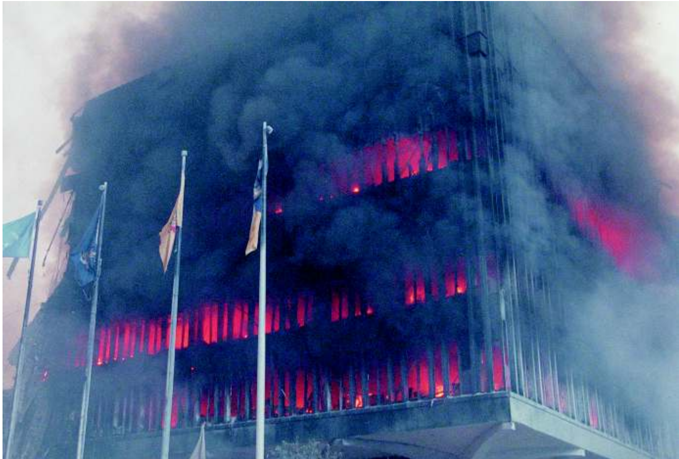
Abbildung 6.2 Gebäude 5 und 6 brannten sehr stark. Dies waren „konventionelle“ Gebäudebrände, z.B. konnte man trotz des dunklen Rauchs gigantische Flammen sehen und fast alle Fenster zersprangen.
