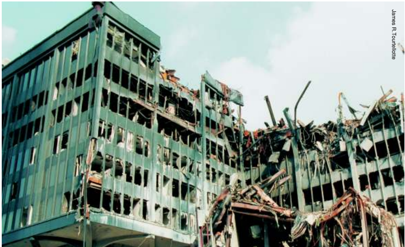
Abbildung 6.3 Gebäude 6 überstand das verheerende Feuer ohne zusammenzubrechen. Die herabfallenden Trümmer der Türme zerstörten einen Teil des Gebäudes; nicht das Feuer richtete diesen Schaden an (vergleiche Abbildung 6.4).
